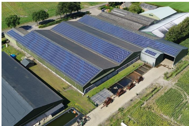
Zonnepanelen op de drie loodsen
